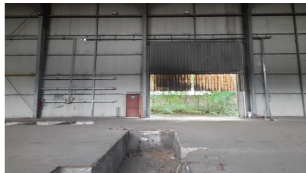
Particolare porzione pavimentazione
