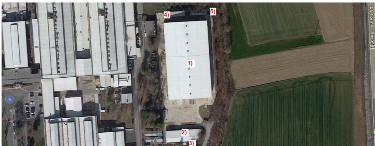
Foto aerea con indicazioni corpi di fabbrica
