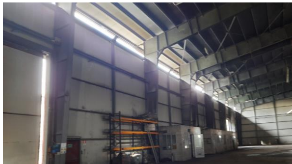
Blocco uffici interno capannone
