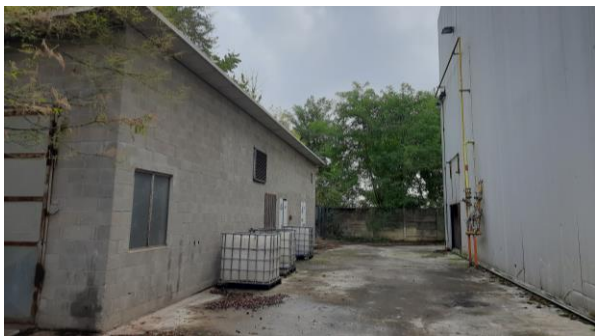
Officina a locali tecnici
