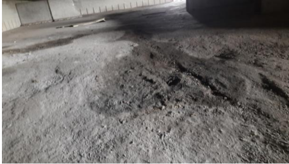
Particolare porzione pavimentazione
